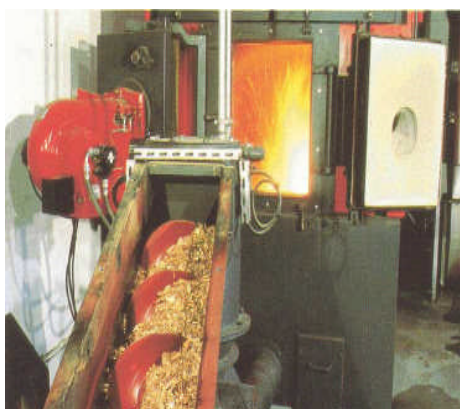
Figur 6.1 viser biokjele med skruemating av flis
